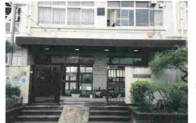
大森第七中学校旧校舎(平成30年9月撮影) 提供:大森第七中学校
