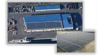
太陽光パネルの整備
