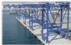
耐震強化岸壁・免震クレーン
