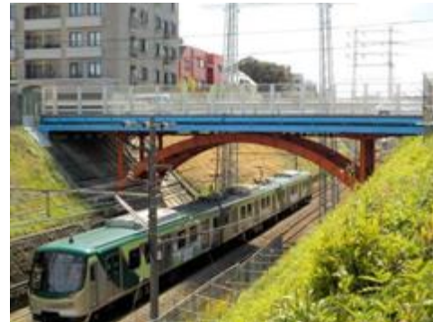
写真1 区が管理する最も古い橋梁 (笹丸橋 昭和2年竣工)
