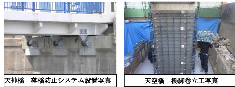
写真1 耐震補強の整備事例
