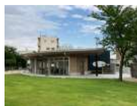
公園施設の利活用の推進 (森ヶ崎緑華園管理棟)
