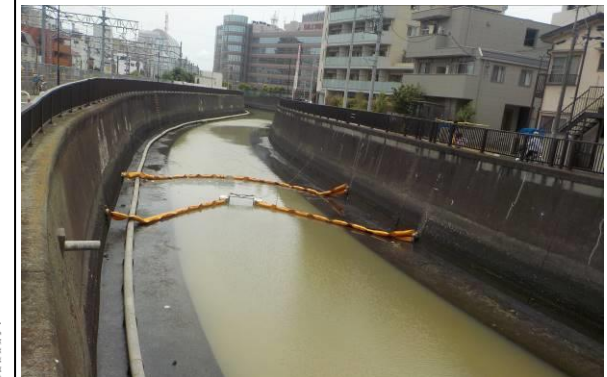
写真 2.2 放流管配管状況
