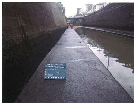
写真 2. 11 施工後写真（一本橋上流側）
