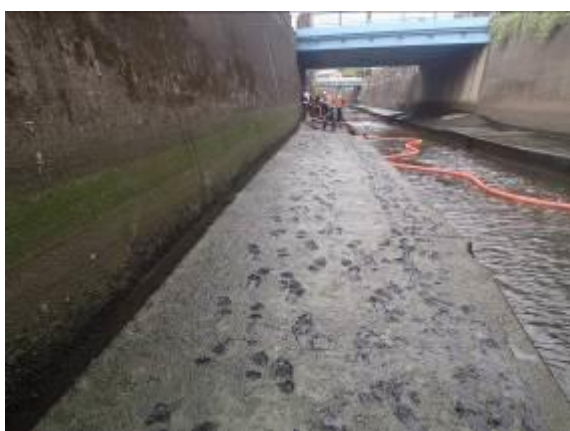
写真 2. 10 施工前写真（一本橋上流側）
