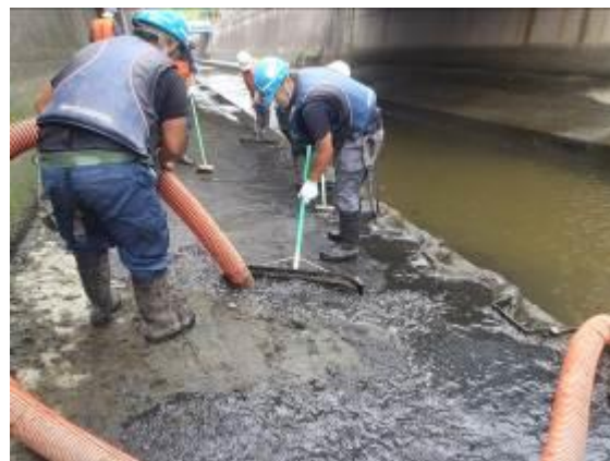
写真 2. 9 施工状況写真（近景）
