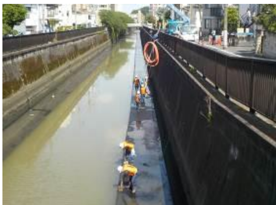
写真 2. 8 施工状況写真（遠景）
