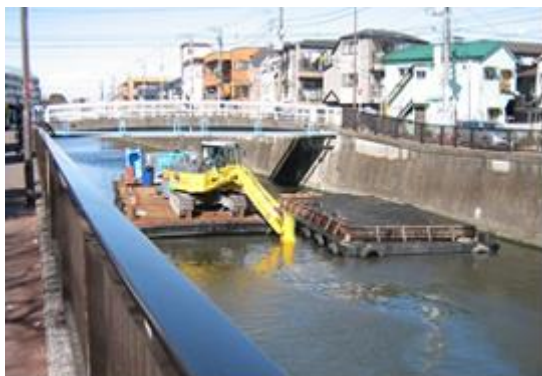
写真 2.4 バックホウによる浚渫状況
