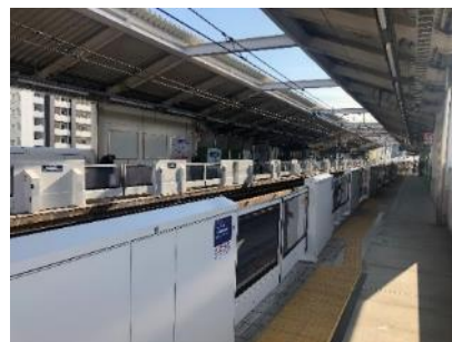
ホームドア設置後のホームの状況
