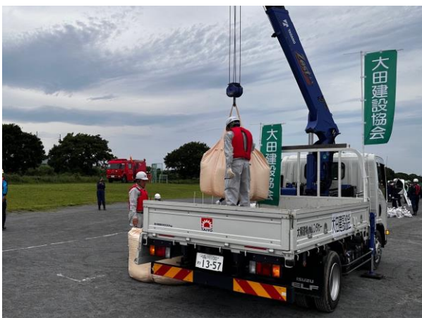
大型土のう工法
