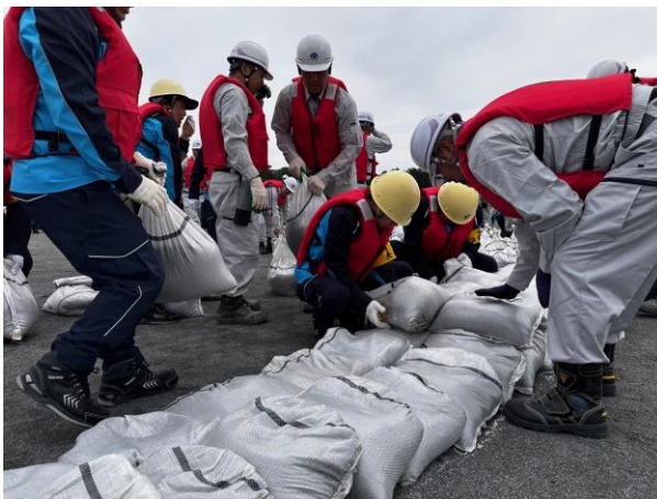
積土のう工法
