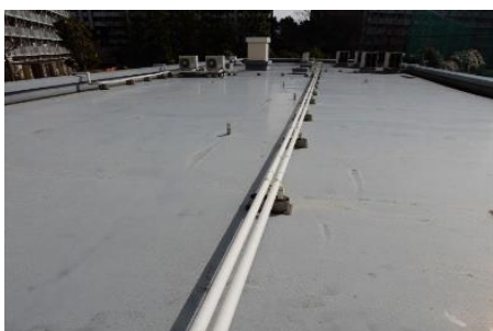
塗膜防水の防水層は良好
