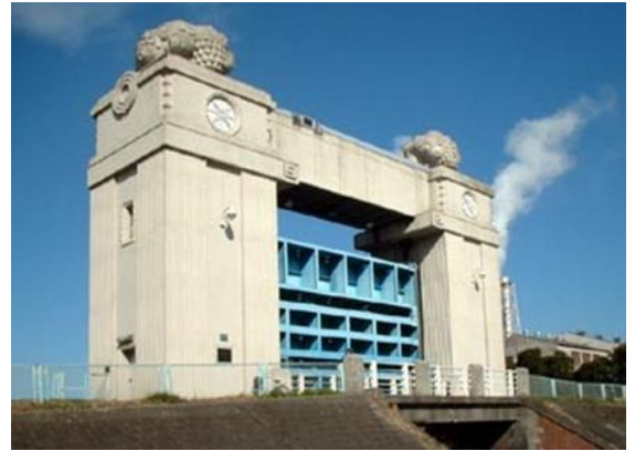
川崎河口水門(川崎区港町66番地)昭和3年完成
