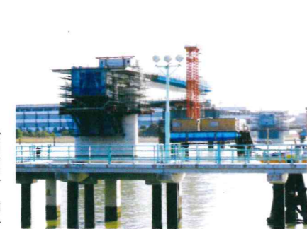
連絡道路の工事が急ピッチで進められています
