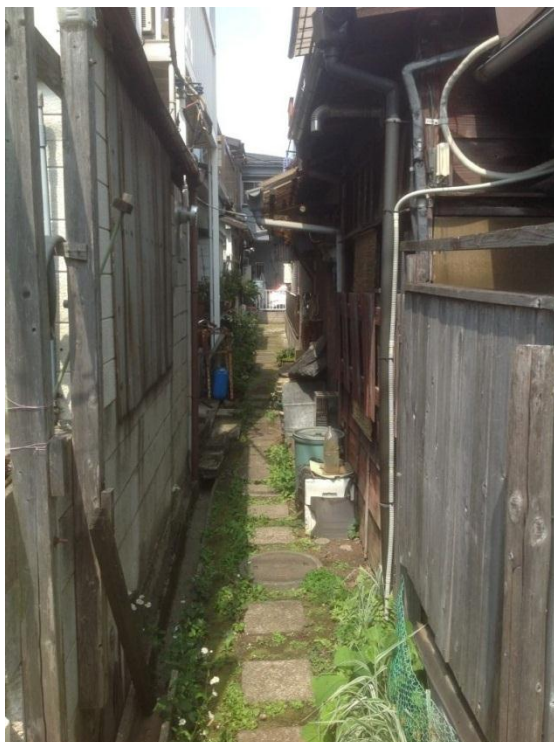
木造住宅が密集する地域は延焼の危険性が高く、災害時の避難も困難になりやすい
