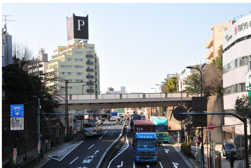
架替え整備完了後の新馬込橋
