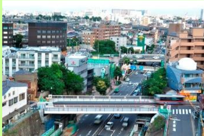
新規開通した新馬込橋
