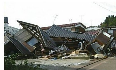
倒壊家屋の現場写真
