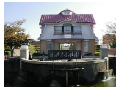
田園調布旧駅舎
