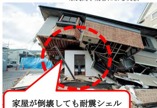
家屋が倒壊しても耐震シェルターは壊れずに残ります。
