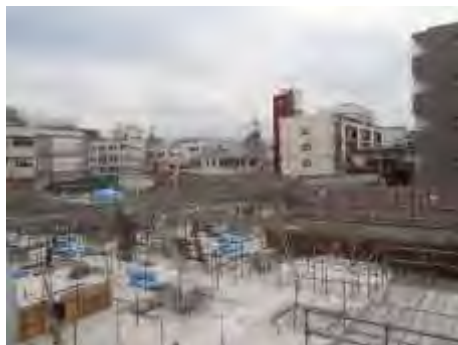
東六郷小学校校舎改築工事 経過
