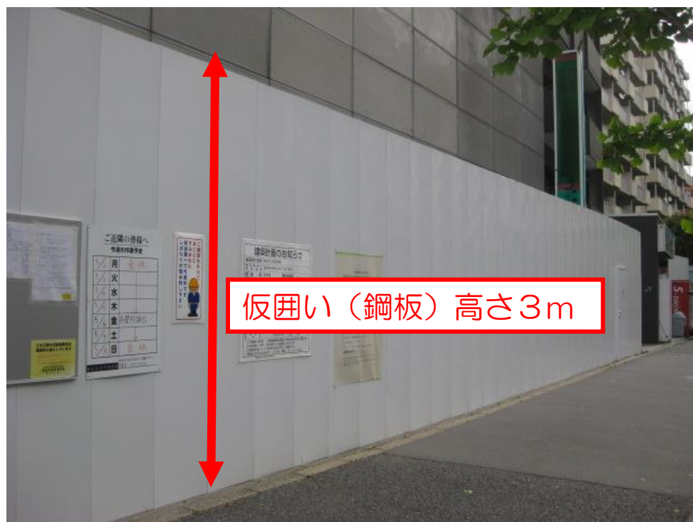
【 外周仮囲い（鋼板） 参考例 】
