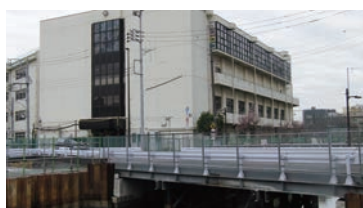
工事中の富士見橋と大森八中
