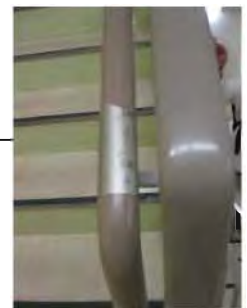
手すりに点字案内板
