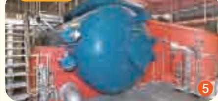
焼却炉から発生する排ガスの熱で水を蒸気に変えます。
