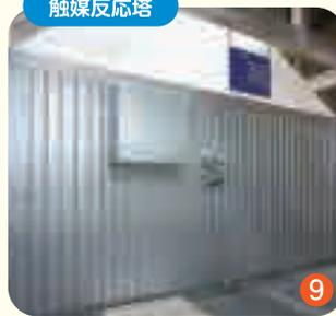
排ガスに残っている有害物質を分解します。
