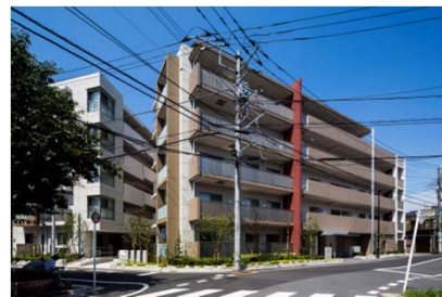
京島三丁目地区防災街区整備事業 [墨田区] (URによる事業)
