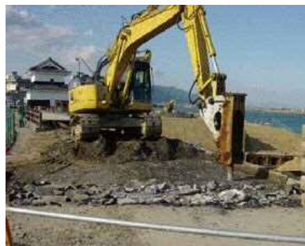
躯体破碎 (ブレーカー)
