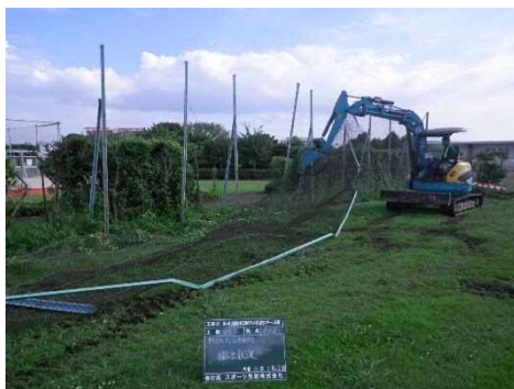
フェンス撤去
