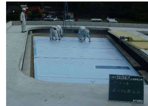
床パネル設置
