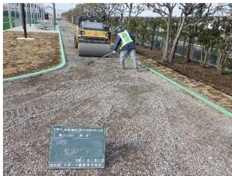
路盤整生、転圧
