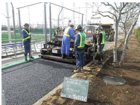
AS敷均し (フィニッシャー使用)
