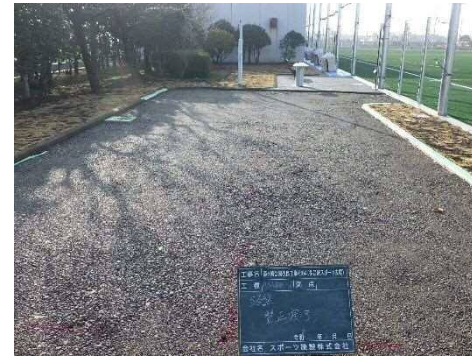
路盤整生完了
