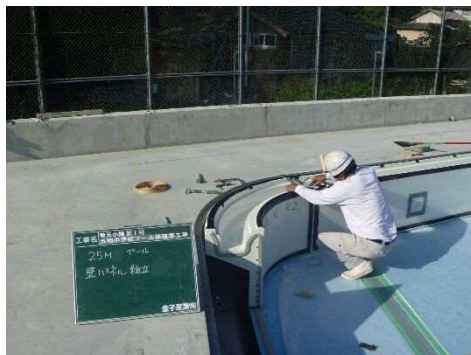
壁パネル設置
