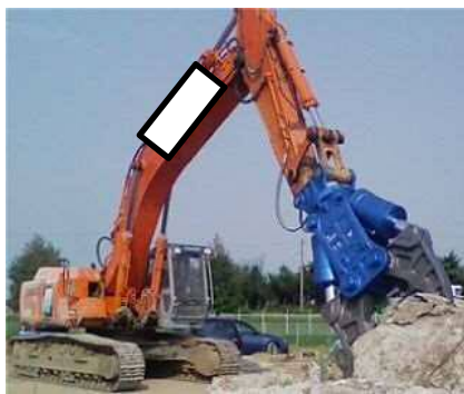
躯体破碎 (大割機)
