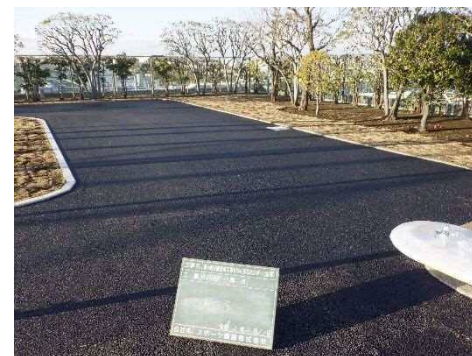
アスファルト舗装完了
