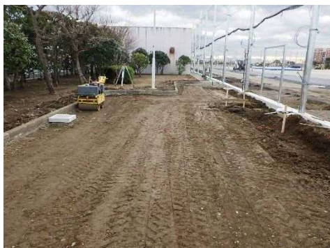
路床整生完了
