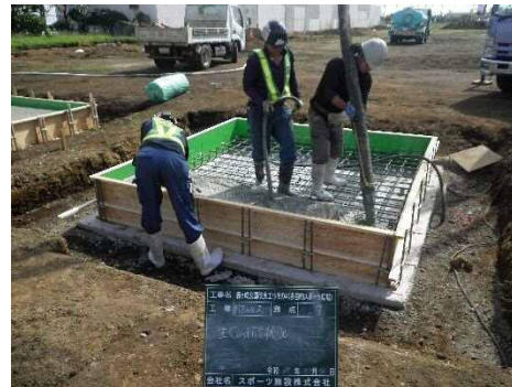
基礎コンクリート打設
