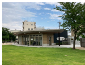
公園利活用の推進 (森ヶ崎緑華園管理棟)
