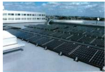
<太陽光パネルの設置>
