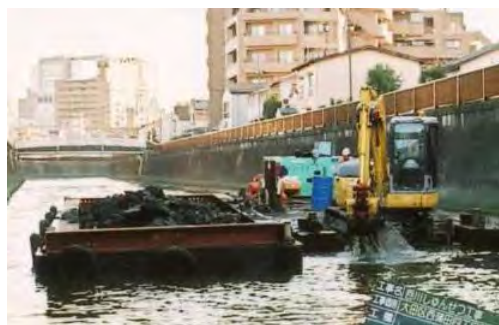
バックホウによる河床整正工事
