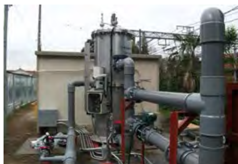
高濃度酸素水による浄化実験
