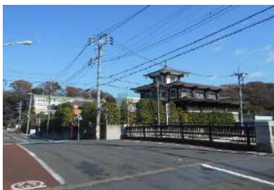
▲現在の呑川霊山橋付近の様子
