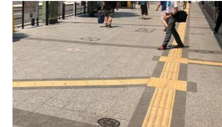
輝度比を確保するために縁取りが行われている事例
