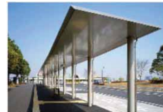
主要構造材：鉄骨、 屋根材：アルミ形材
