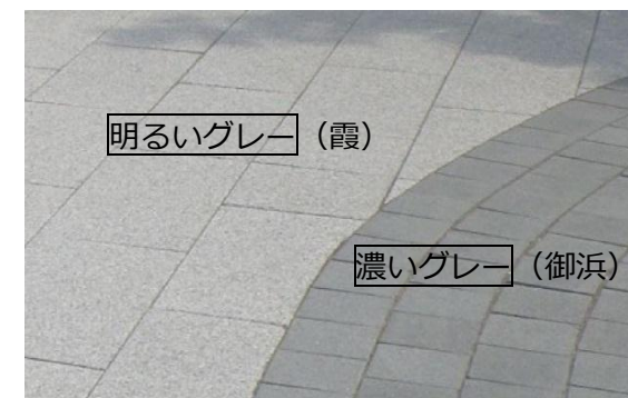
色合いのイメージ ※実際に使用する舗装材の大きさは 30cm 角
