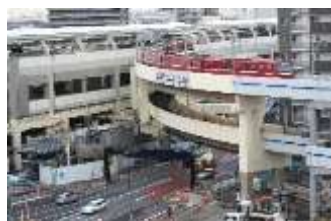
京浜急行線連続立体交差事業の 高架化
