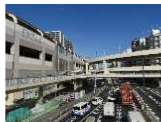
京浜急行線連続立体交差事業の高架化
