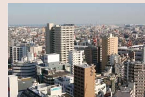
連続立体交差事業が進む京急蒲田駅周辺地区
