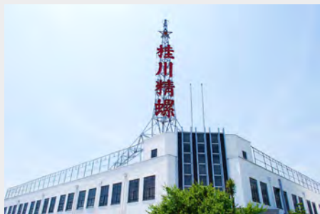
桂川精螺の工場建築 [矢口3-24-1]
