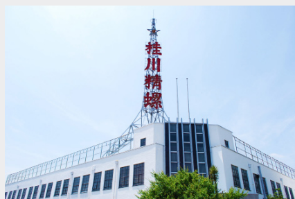
桂川精螺の工場建築 [矢口3-24-1]
