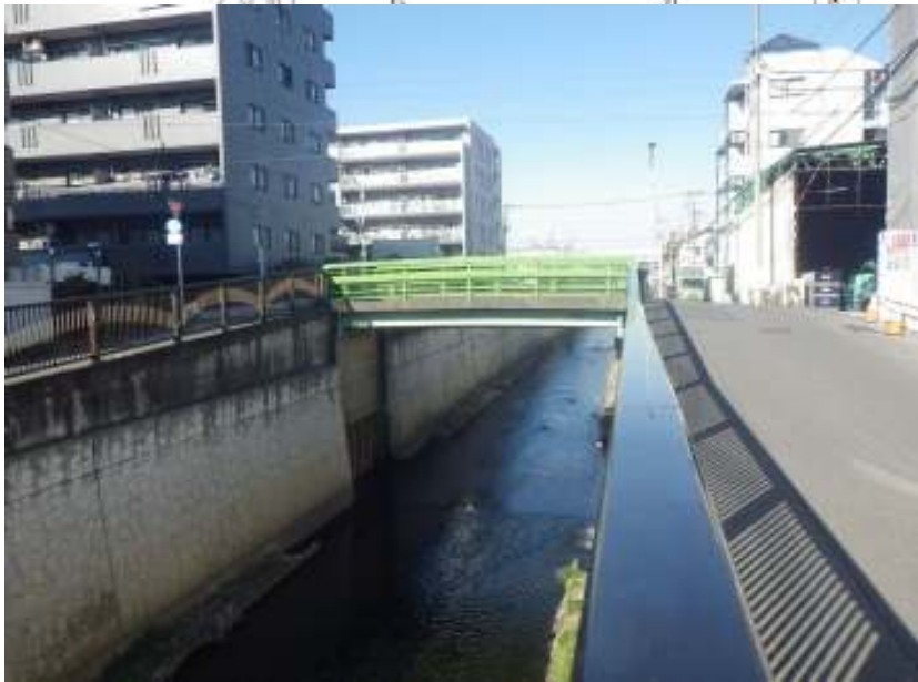
④橋梁全景(下流から上流方向)
