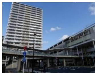
京急蒲田駅周辺地区
