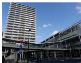
京急蒲田駅周辺地区
