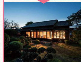
かつめてい 宿泊施設に改修した勝目邸
