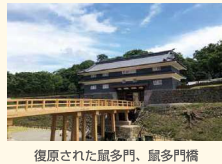
復原された鼠多門、鼠多門橋
