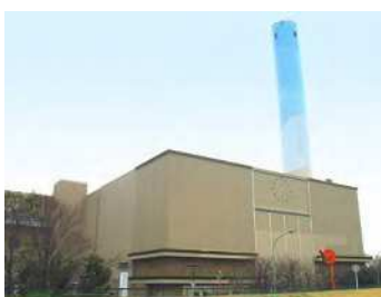
②防災拠点としての機能 【主な施設の例】 大規模救出救助活動拠点候補地（多摩川清掃工場）
