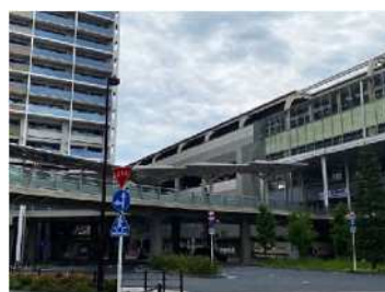
③非浸水動線としての機能 【主な施設の例】 建物をつなぐ歩行者デッキ等（京急蒲田駅ベデストリアンデッキ）
