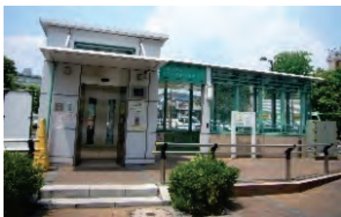
駅前広場、地下自転車駐車場の整備
