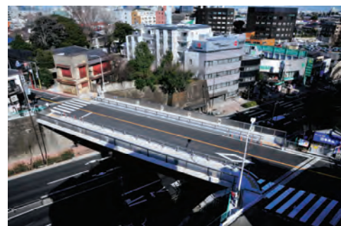
新馬込橋（平成26年度竣工）
