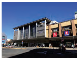
高幡不動駅（橋上駅舎化）
