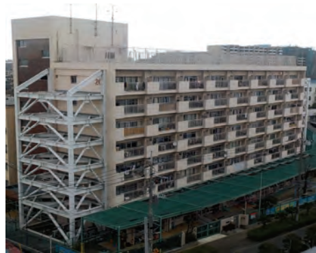
区立施設（耐震補強）
